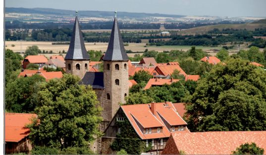
Klostertürme des Westwerks
